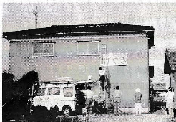
近所の方が作ってくださった看板を取り付けているところ
